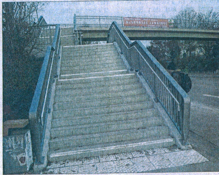
Mit Noppenplatten und durchlaufendem Metallgeländer ist die Brücke nun ausgestattet.
